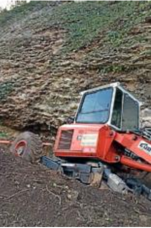
Lavori per costruire la scala
